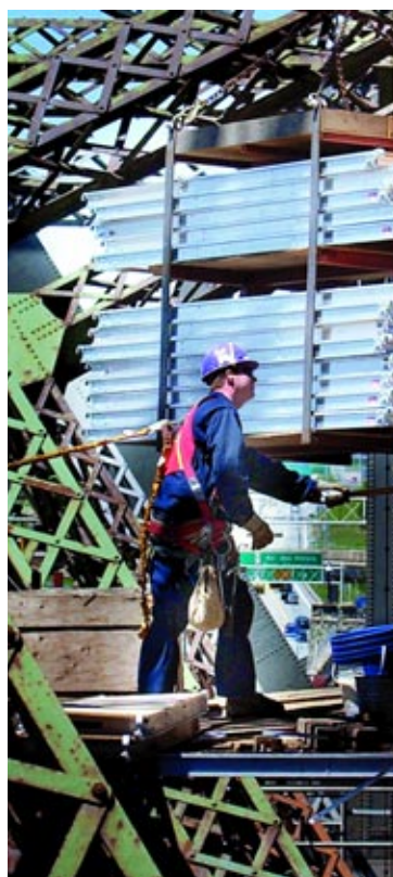
La construction des échafaudages, une œuvre en soi. Elle est assurée par les confrères monteurs d'acier de structure de la section locale 711.
