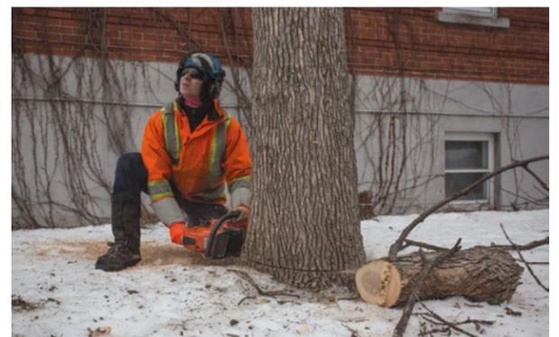
Quant au bruit, non seulement les scies électriques avec batterie réduisent les dangers reliés aux niveaux des décibels, mais cela augmente nettement la qualité de la communication entre les travailleurs qui peuvent dorénavant s'entendre sans être obligés d'arrêter le moteur des scies.
