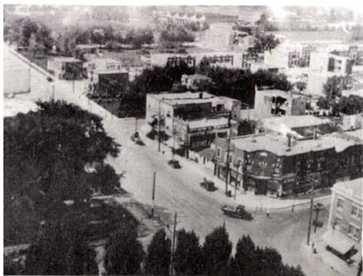
Vue prise du clocher de l'église Saint-Alphonse dans les années 30. On y voit bien le pâté de maisons sur lequel s'édifie aujourd'hui le 545 Crémazie, siège social du FSTQ. La porte d'entrée de l'actuel édifice et celle de l'immeuble d'alors sont à la même place, angle Crémazie et Lajeunesse... mais à l'époque, c'était l'entrée d'un salon mortuaire! Avis aux superstitieux.
