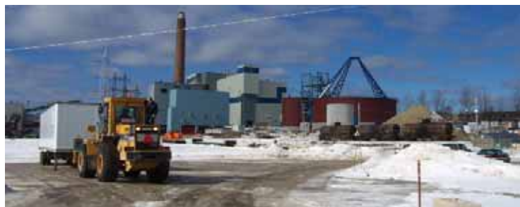
L'usine, après l'arrêt des travaux, en février dernier.
